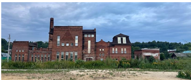
Рис. 7. Юрьевецкий пивзавод. Современное состояние здания. Август 2025 г. Фото автора Fig. 7. Yuryevets brewery, 2025
