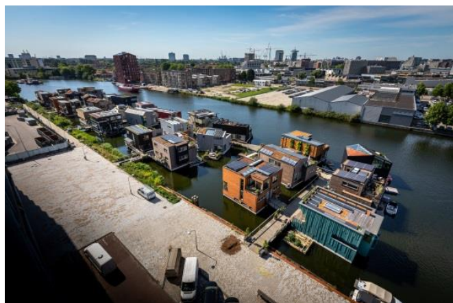
Рис. 5. Вид на «Схонсхип» сверху 4 Fig. 5. View over the Schoonschip
