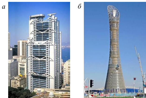
Рис. 3. Ствольные конструктивные системы:
