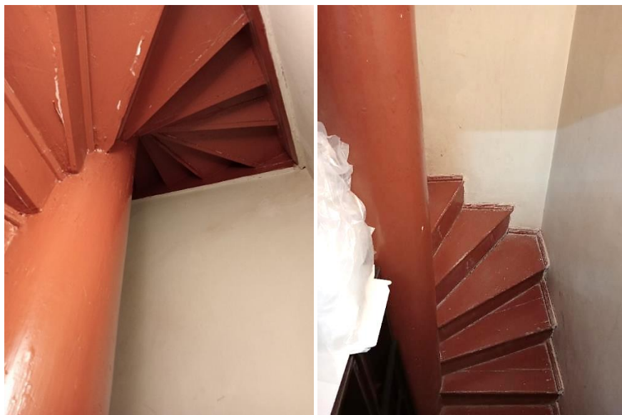
Рис. 14. Винтовая лестница в лестничной клетке, квадратной в плане. Первый корпус Томского государственного университета. Фото А. Кутукова, июль 2024 г.
