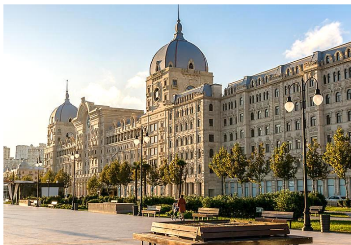
Рис. 9. Надстройка этажей по ул. Физули, г. Баку 9 Fig. 9. Floor superstructure on Fuzuli Street, Baku
