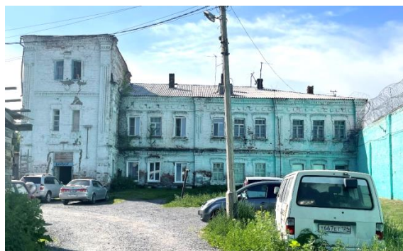
Рис. 15. Современный вид каменного корпуса завода по ул. Слободчикова, 2Б. Фото Д.В. Прислоновой, июнь 2023 г.
