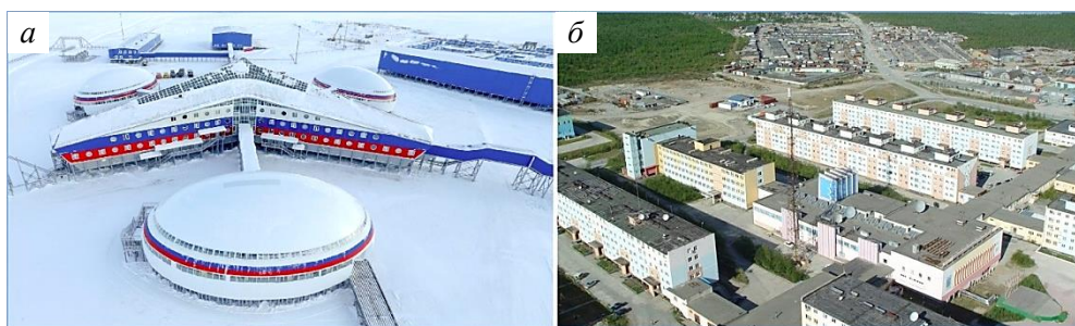
Рис. 4. Станция «Арктический трилистник» 19 (а); объединение крытыми переходами в масштабе городского квартала, г. Удачный 20 (б)
