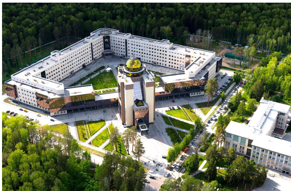
Рис. 5. НГУ. Новое (слева) и старое (справа) здания 2 Fig. 5. New (left) and old (right) buildings of Novosibirsk State University
