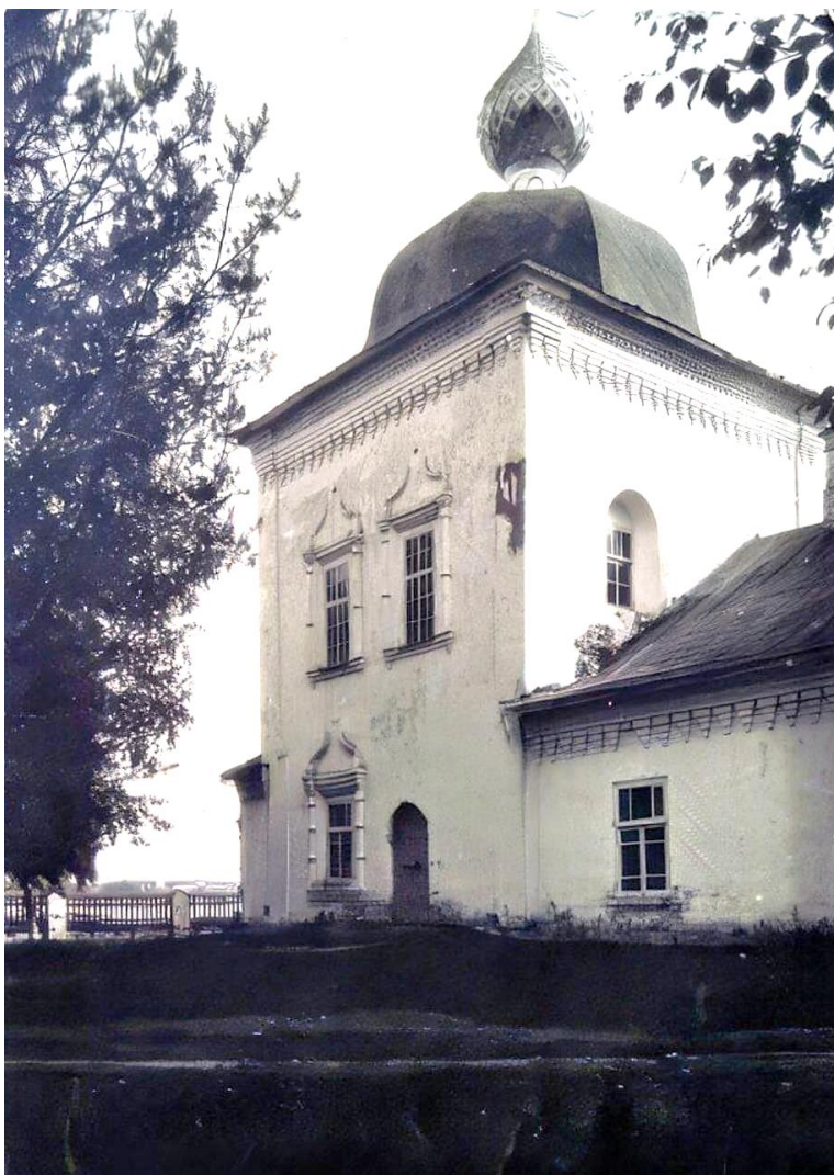
Рис. 14. Сретенская церковь. 1919 г. Основной объем храма. Вид с северо-запада Fig. 14. Sretenskaya Church, 1919
