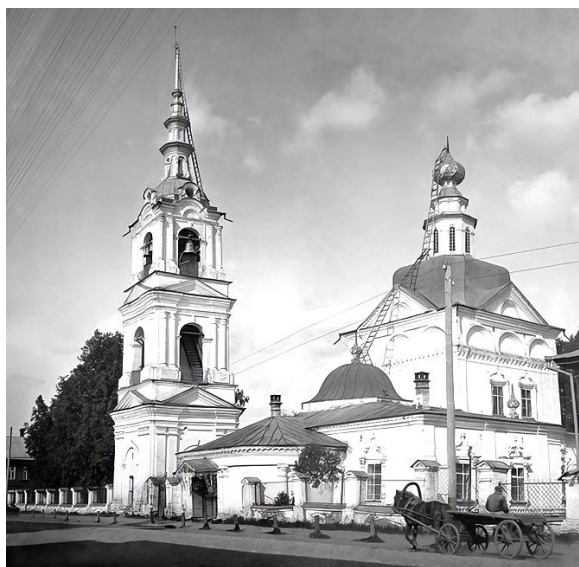
Рис. 9. Преображенская церковь. Фото 1914 г. Фотоархив ИИМК РАН Fig. 9. The Transfiguration Church, 1914
