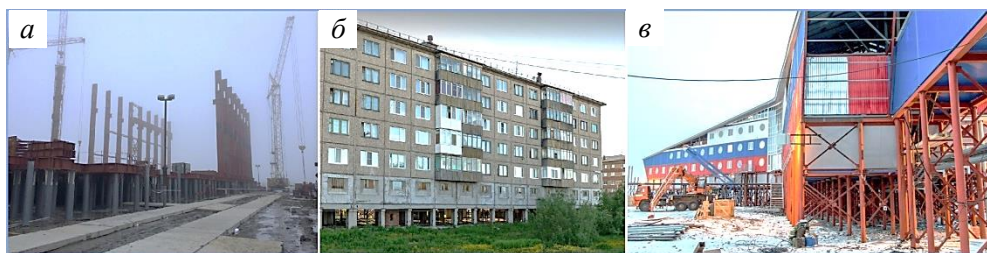
Рис. 3. Свайный фундамент на Ямале 13 (а); жилой дом на забивных бетонных сваях 14 (б); пространственный несущий свайный каркас базы «Арктический трилистник» 15 (в)
