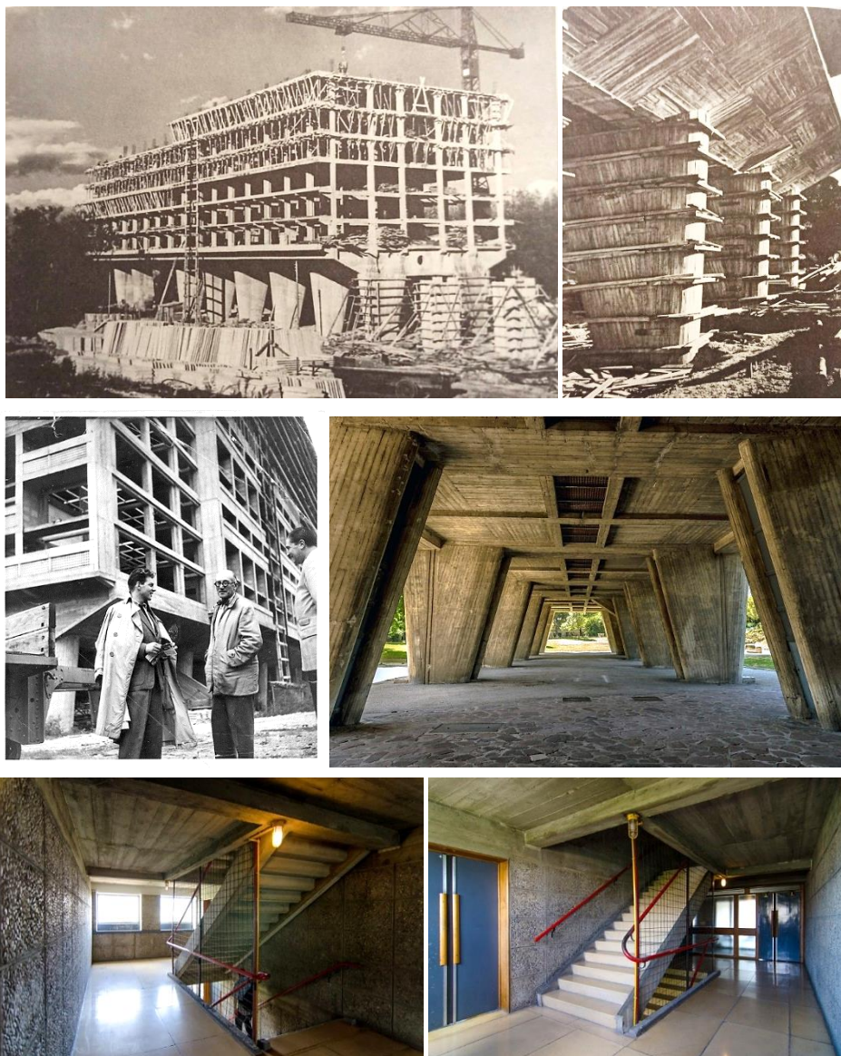
Рис. 1. Процесс монтажа Марсельской «жилой единицы» 3 ; ее лестничная клетка 4 Fig. 1. Installation process of Unité d'Habitation
