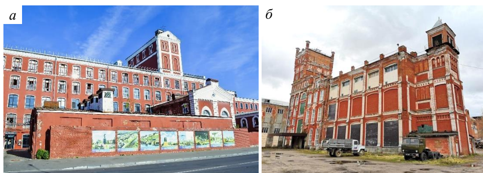
Рис. 8. Бумагопрядильная фабрика С. Морозова в Орехово-Зуеве 12 (а); современное состояние зданий и сооружений фабрики 13 (б)
