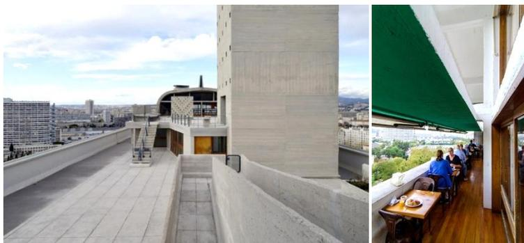
Рис. 20. Ограждение периметра крыши и лоджий Марсельской «жилой единицы»<sup>23</sup>
