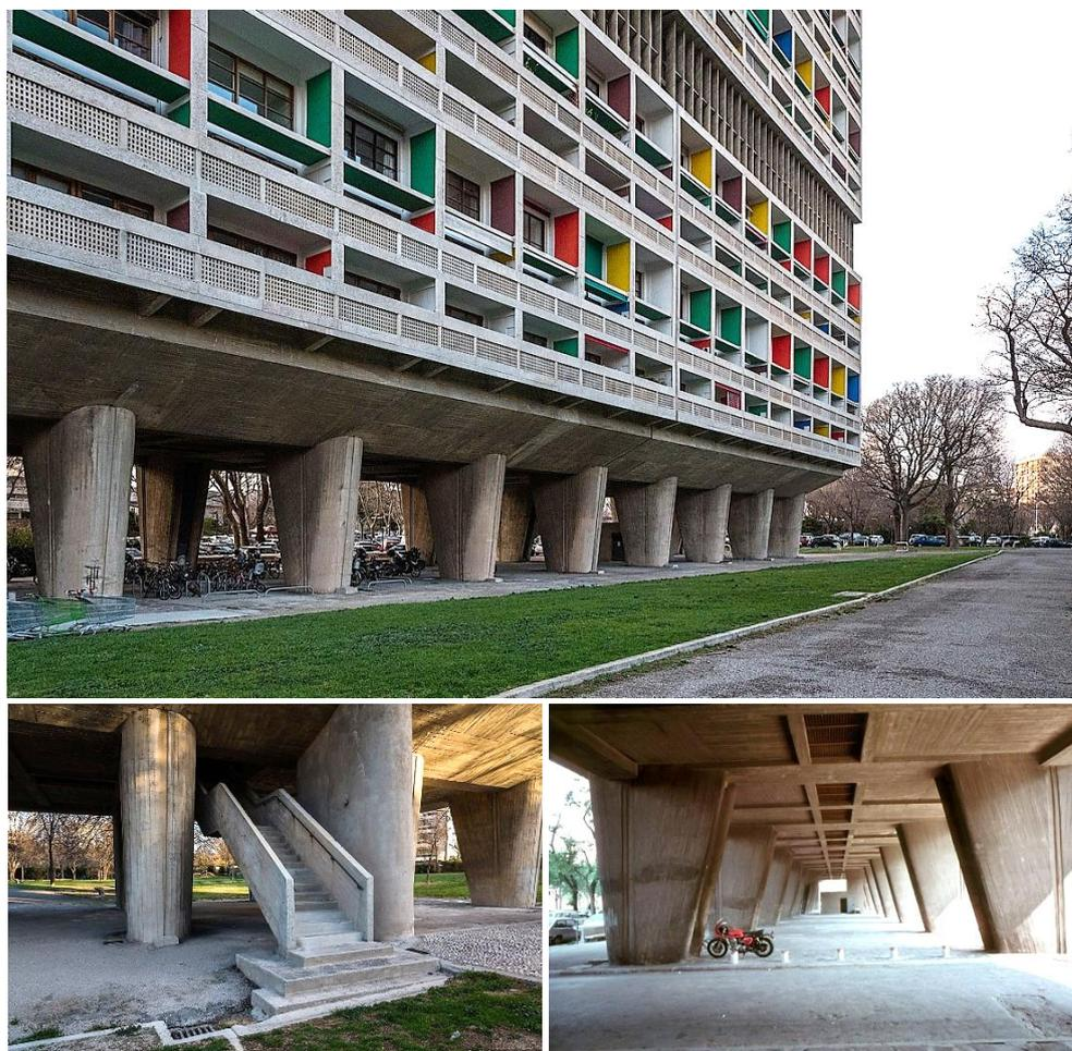
Рис. 10. Опорная структура Марсельской «жилой единицы» в роли автостоянки<sup>12</sup>
