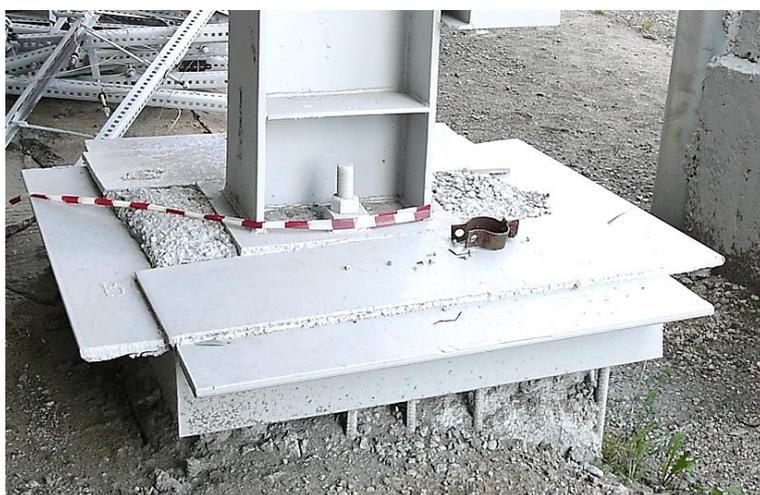
Рис. 2. Бетон пористой структуры в контурной области металлической плиты базы колонны
