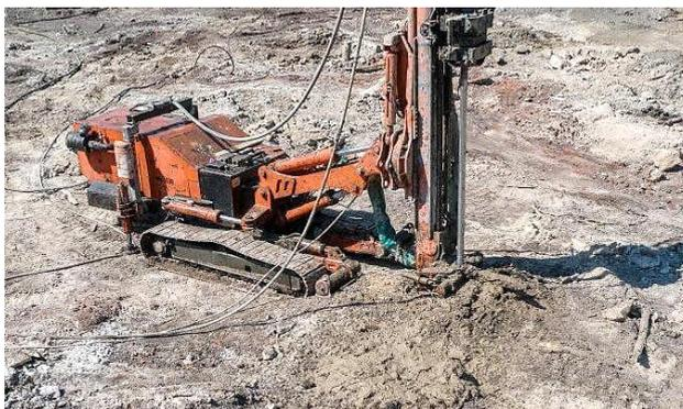
Рис. 6. Производство работ по технологии струйной цементации грунтов
