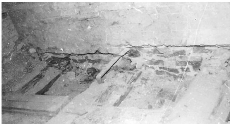
*Рис. 6. Деревянное междуэтажное перекрытие с металлической скобой. ТГУ, I объём. Фото из архива СИ «Сибспецпроектреставрация», 1987 г., автор В.А. Кондратьев*
