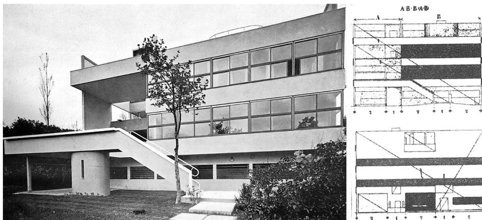
Рис. 15. Южный фасад виллы «Террасы» в Гарше, видовая точка (слева); пропорциональные системы южного (вверху) и северного (внизу) фасадов (справа)<sup>19</sup>
