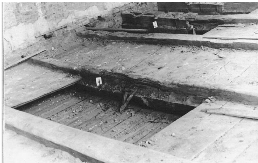
*Рис. 13.* Деструкция балок перекрытия в их средней части. ТГУ. Фото из архива СИ «Сибспецпроектреставрация», 1987 г., автор В.А. Кондратьев
