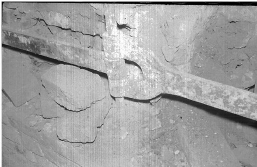
Рис. 8. Металлическая кованая затяжка. ТГУ. Фото из архива СИ «Сибспецпроектреставрация», 1987 г., автор В.А. Кондратьев
