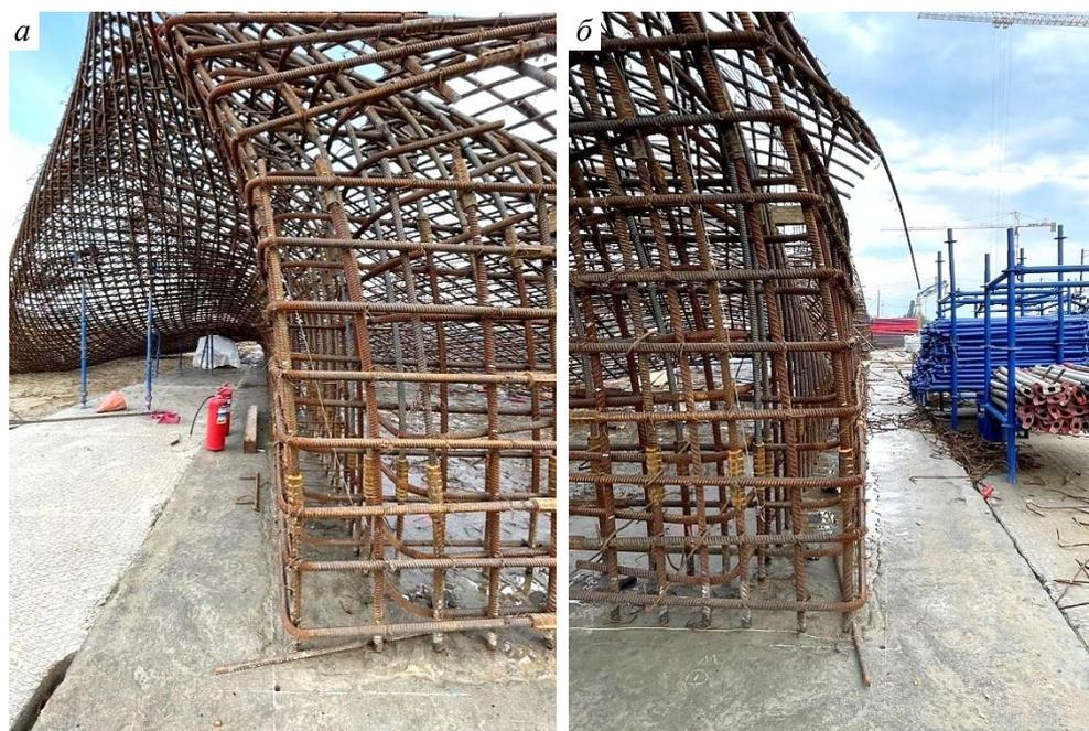
Рис. 1. Общий вид деформации арматурного каркаса:
