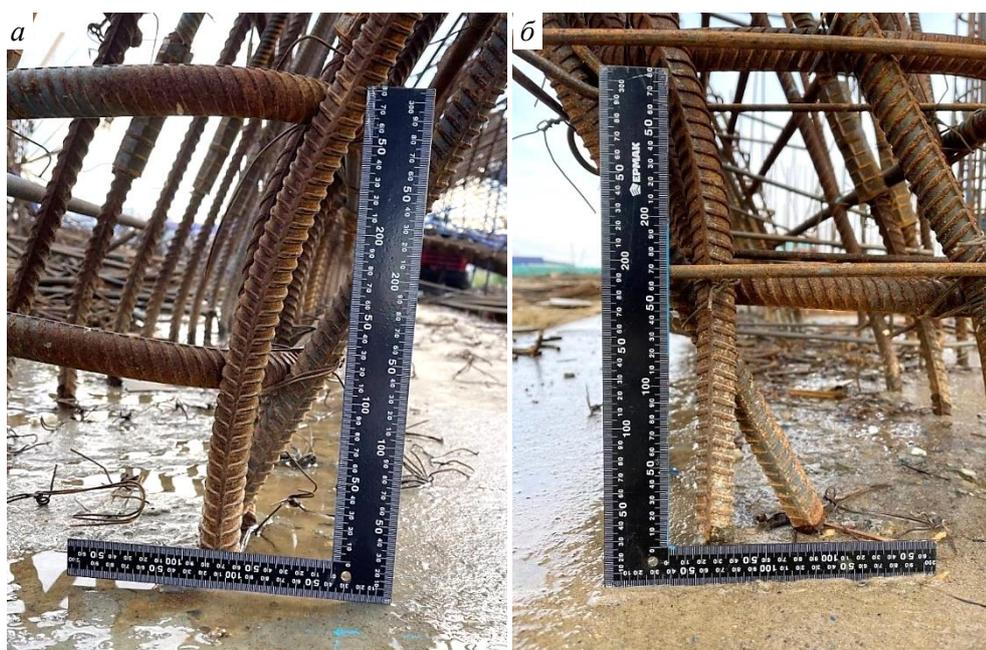
*Рис. 2. Определение угла загиба арматурного выпуска:*
