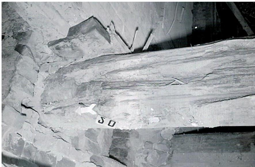
*Рис. 12.* Деструкция балок перекрытия в местах опоры. ТГУ. Фото из архива СИ «Сибспецпроектреставрация», 1987 г., автор В.А. Кондратьев
