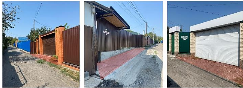
Рис. 4. Фотографии натурных обследований садоводств «Звезда», «Энергия», «Труд». Штриховкой выделены зоны уширения проездов
