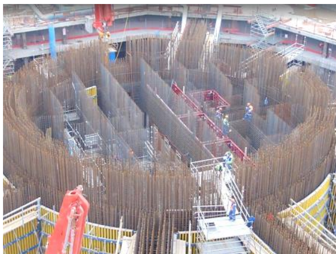
Рис. 14. Армирование стен коробчатого фундамента Fig. 14. Reinforcement of box foundation walls
