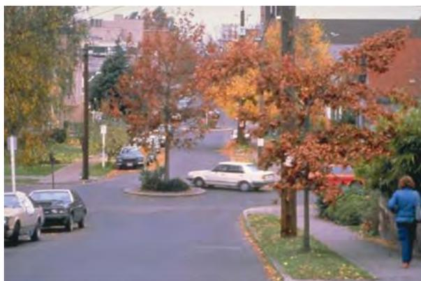
Рис. 21. США. Пример мини-кольцевого пересечения, применяемого для успокоения движения на местных улицах жилых территорий
