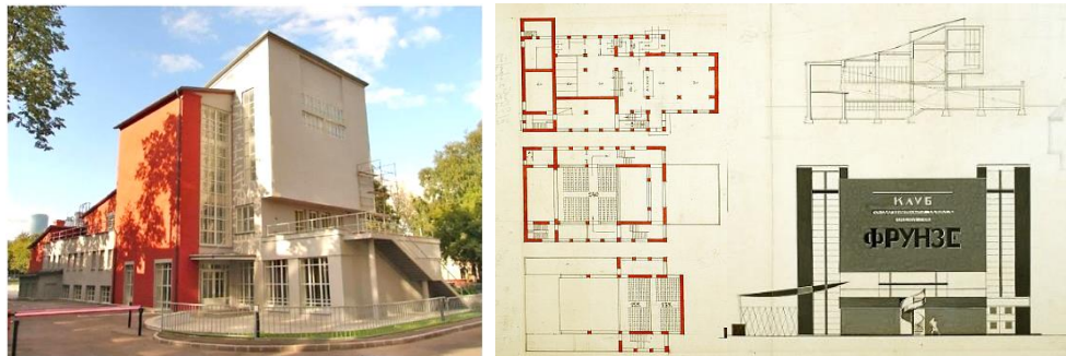
Рис. 3. Здание клуба Дорхимзавода имени М.С. Фрунзе на ул. Бережковская набережная, 28, в Москве. Современный вид (слева) [4]; планировочные решения (справа) (URL: https://otzyv.ru/review/221675/ )
