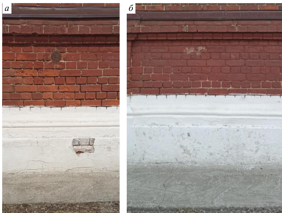
Рис. 7. Состояние кирпичной кладки храма Петра и Павла в Томске. Фото А. Кутукова: а – выветривание раствора в швах кладки; б – кладка, покрытая краской
