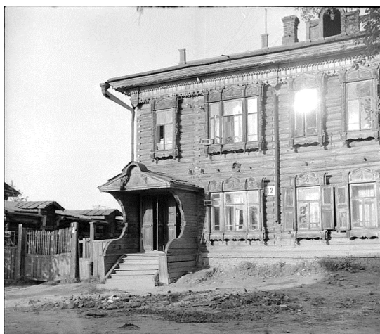
Рис. 2. Фрагмент усадьбы с главным входом по ул. Дзержинского, 12, в г. Томске. Фото П.Н. Коханенко, 1960-е гг.
