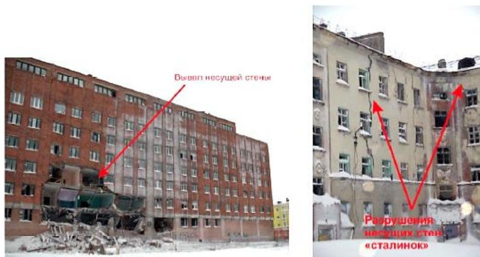
Рис. 1. Разрушение административного здания (слева) и жилого здания (справа) в г. Норильске
