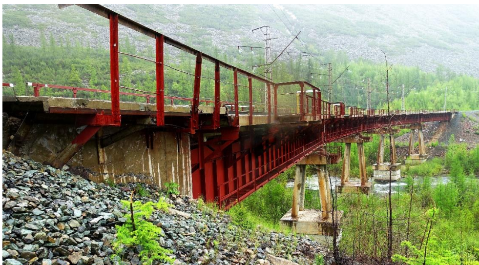
Рис. 1. Общий вид сооружения
