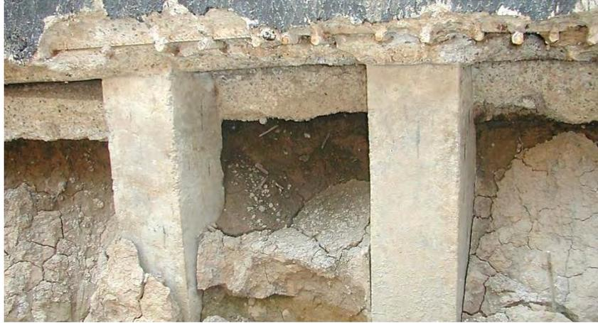
Рис. 1. Фрагмент края нижней части МФП с оголением арматуры нижнего слоя
