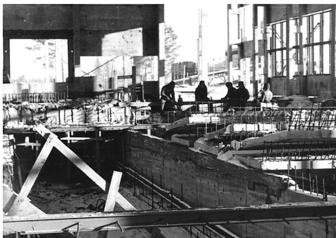
Рис. 6. Наращивание стенки пропарочной камеры завода керамзитобетонных панелей
