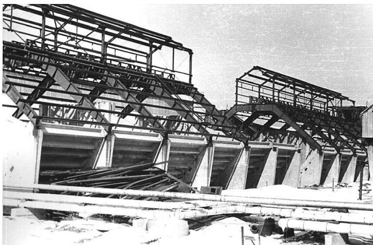
Рис. 8. Демонтаж деформированного склада инертных материалов
