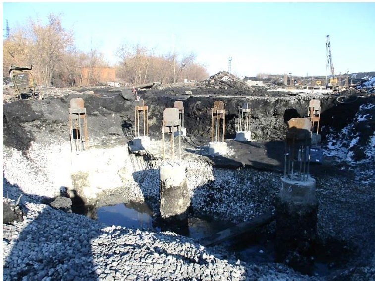
Рис. 3. Подготовленные опытные сваи
