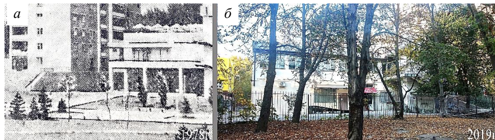
Рис. 4. Здание комбината общественного питания «Росинка» (фото М. Дзябенко [7]): а – состояние в 1978 г.; б – в 2019 г.
