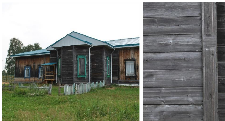
Рис. 16. Перестроенная Пророко-Ильинская церковь, в настоящее время используется под общественные функции с. Новоильинка. Вид со стороны алтарной части и фрагмент стены с обшивкой и пилястрой. Фото Е.В. Ситниковой, 2019 г.
