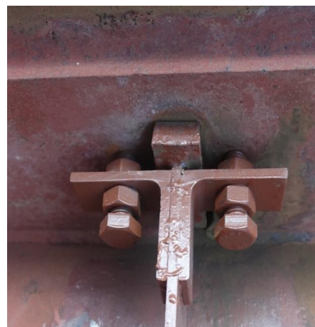
Рис. 8. Конструктивное решение по профилактике S-образного изгиба стенки главной балки
