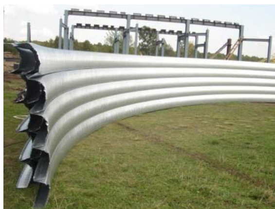
Рис. 2. Монтажный блок из гнуто-листовых тонкостенных профилей
