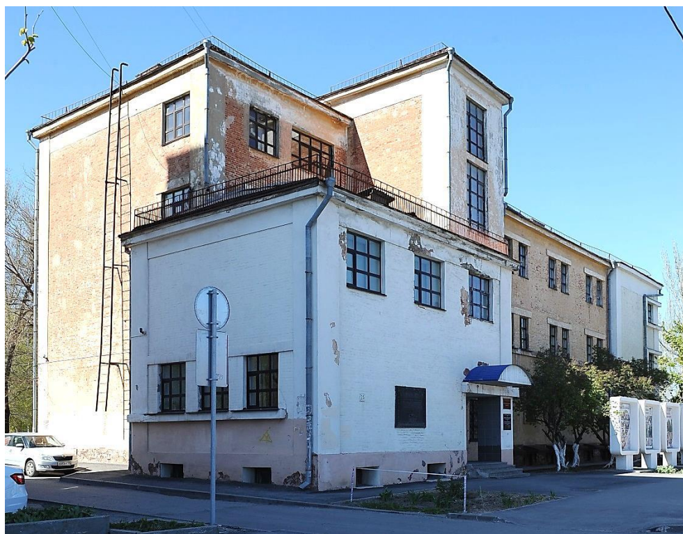
Рис. 8. «Дом для приезжих» Сталинградского тракторного завода. Современное состояние (Фото Е.А. Денисюка)
