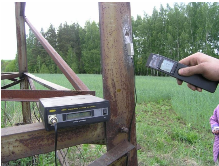
Рис. 2. Процесс измерения скорости ультразвука с поправкой на реальную температуру металла опоры
