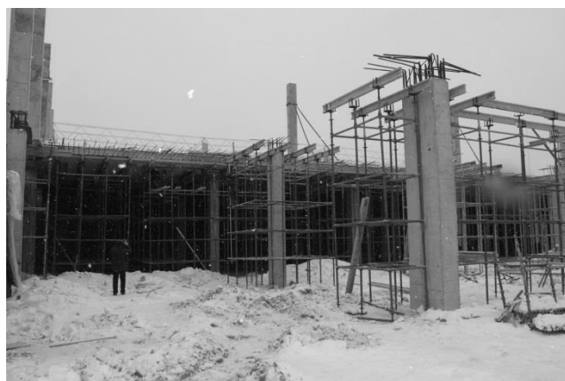
Рис. 4. Общий вид участка монолитной балочной плиты перекрытия толщиной 300 мм на строительстве «ТЦ Стройпарк» по адресу г. Томск, пр. Комсомольский
