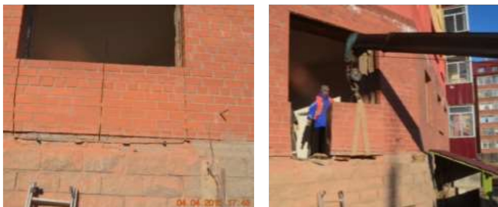
Рис. 1. Процесс извлечения фрагментов кирпичной кладки из стены здания
