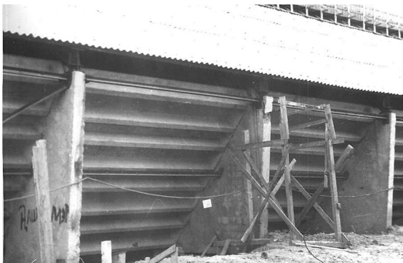
Рис. 7. Разрушение опор складов инертных материалов завода железобетонных конструкций БСИ ТНХК
