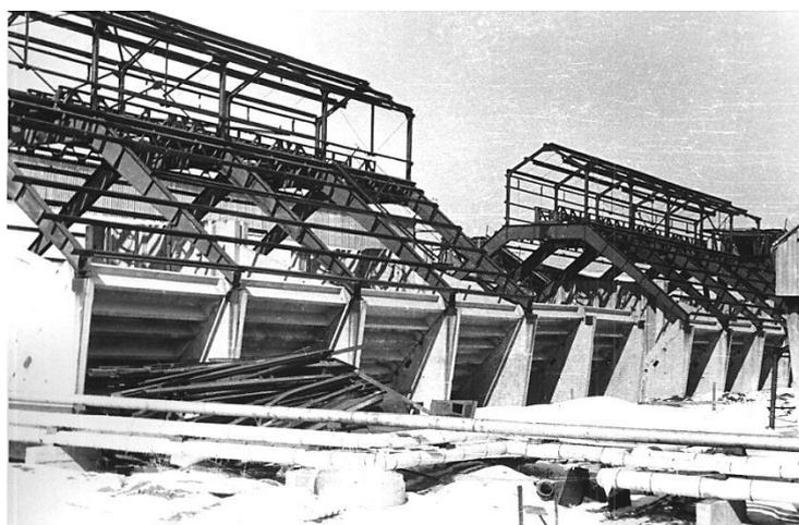
Рис. 8. Демонтаж деформированного склада инертных материалов
