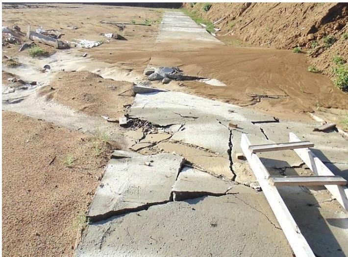
Рис. 1. Разрушение бетонной подготовки под фундаменты подпорных стенок
