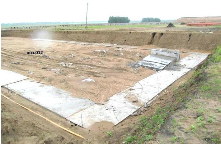
Рис. 2. Демонтаж возведенных фундаментов под резервуары
