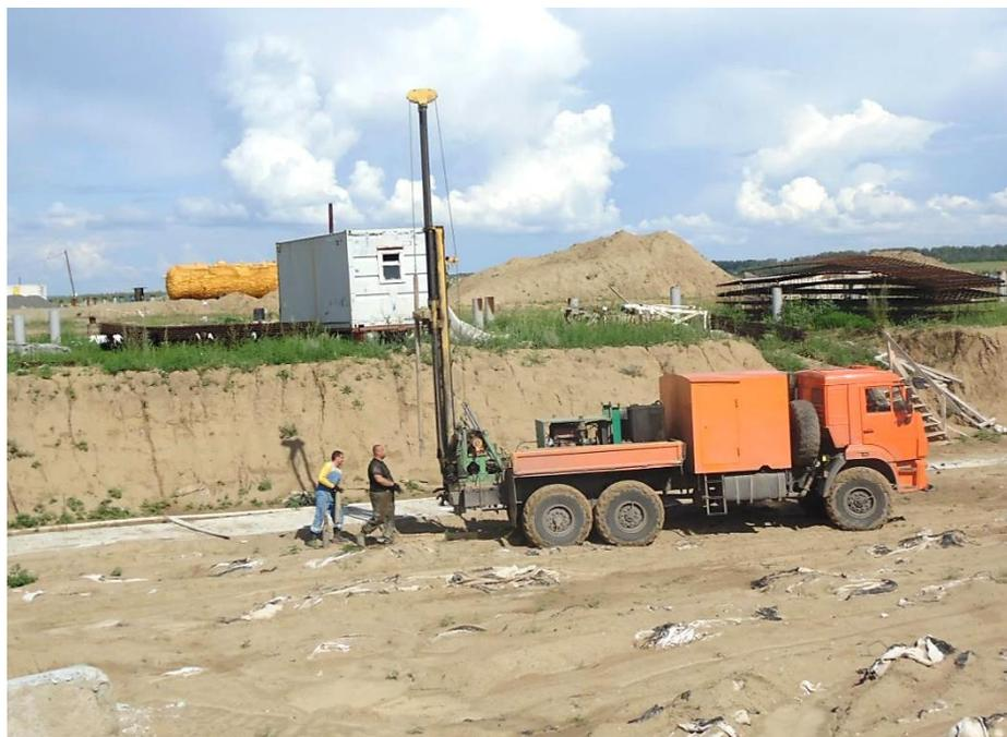
Рис. 6. Бурение скважины в котловане объекта (2017 г.)
