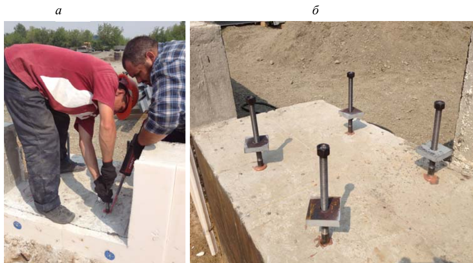
Рис. 2. Установка (а) и уже установленные (б) химические анкера по технологии компании Hilti
