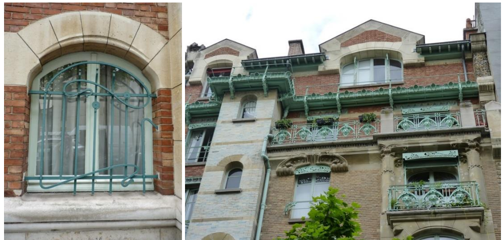
Рис. 7. Замок (Кастель) Беранже. Фрагменты фасада со стороны Rue Jean de la Fontaine [11] (URL: http://interior.lv/ru/brinumaina-gimara-pasaule/ )
