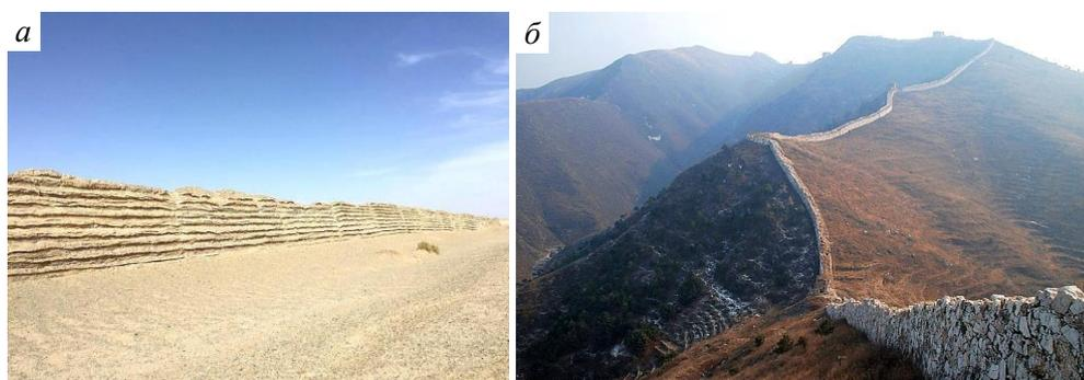
Рис. 24. Фрагменты Великой Китайской стены, построенные из спрессованной глины (а) и из камня (б) (<https://avatars.mds.yandex.net/get-pdb/1365646/f537d698-c26b-4e28-8ce3-c65043c1ea23/s1200>)
