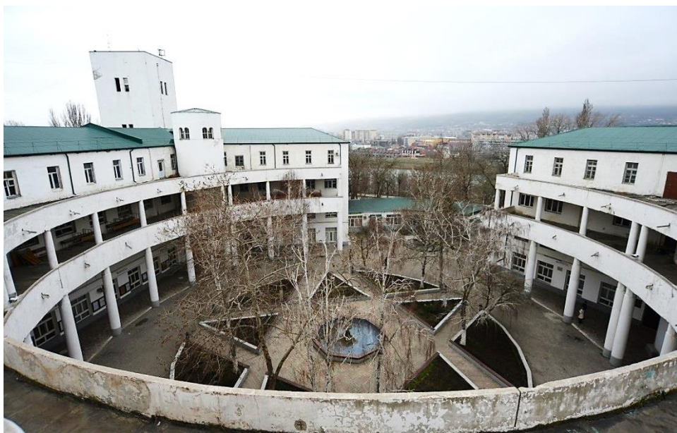
Рис. 6. Внутренний двор. Вид в сторону Вузовского озера. Современное состояние (Фото Е.А. Денисюк)
