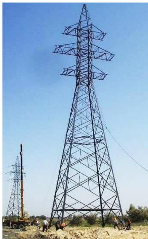
Рис. 4. Общий вид смонтированной оптимальной опоры У110-2+14.
