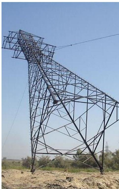
Рис. 3. Оптимальная анкерно-угловая опора У110-2+14 в процессе монтажа
