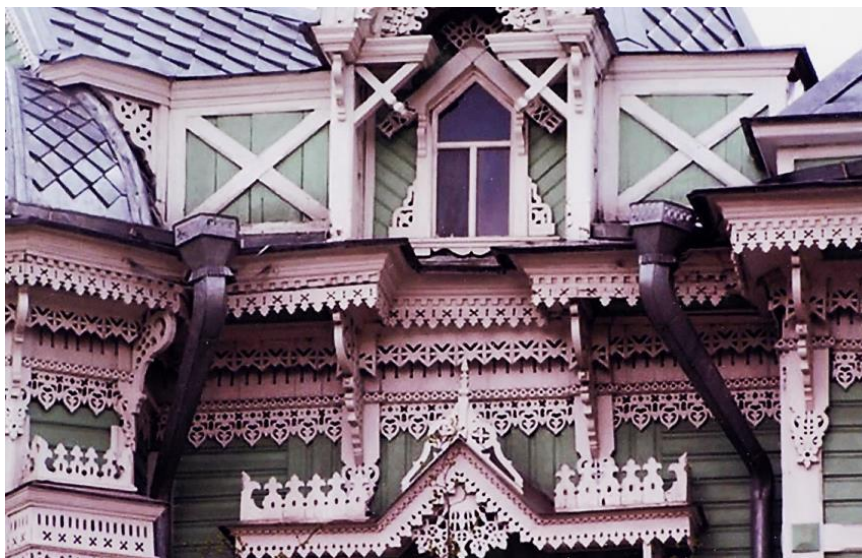
Рис. 15. Томск. Фрагмент главного фасада особняка на ул. Белинского, 19. Фото автора, 2005 г.
