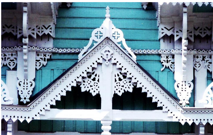
Рис. 16. Томск. Фрагмент фасада особняка С.В. Хомича на ул. Белинского, 19 (1904 г.). Фото автора, 2005 г.
