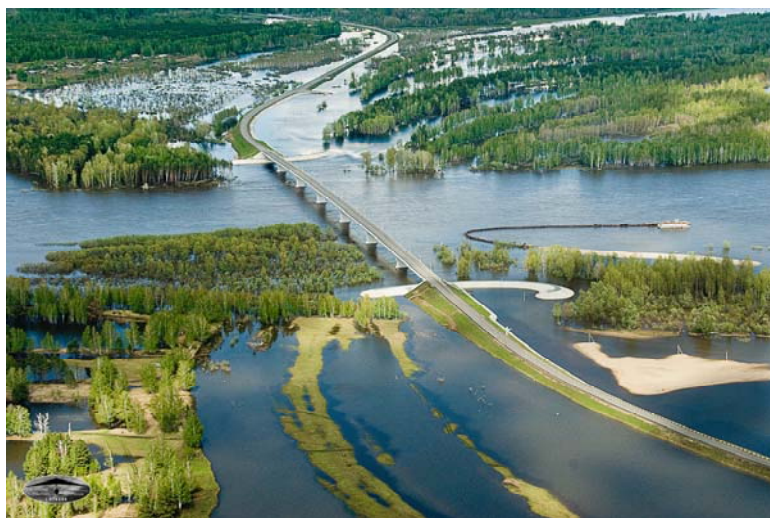
Рис. 1. Мост через р. Чулым
