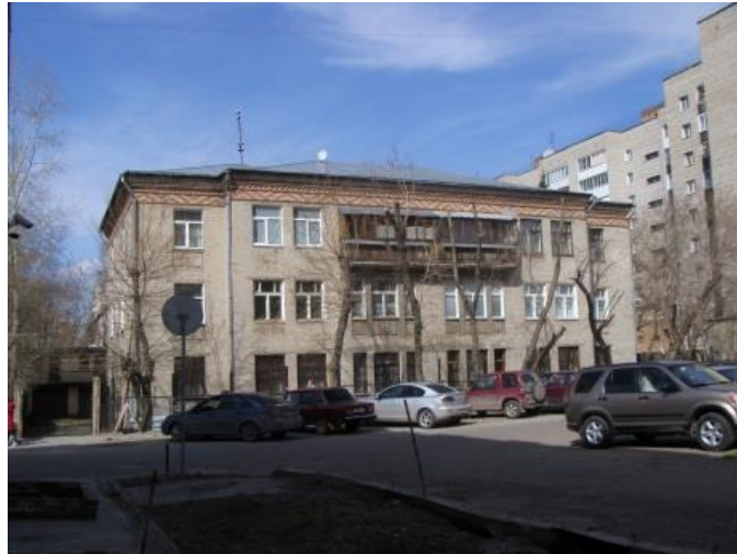
Рис. 9. Типовой жилой дом по ул. Савиных, 16
