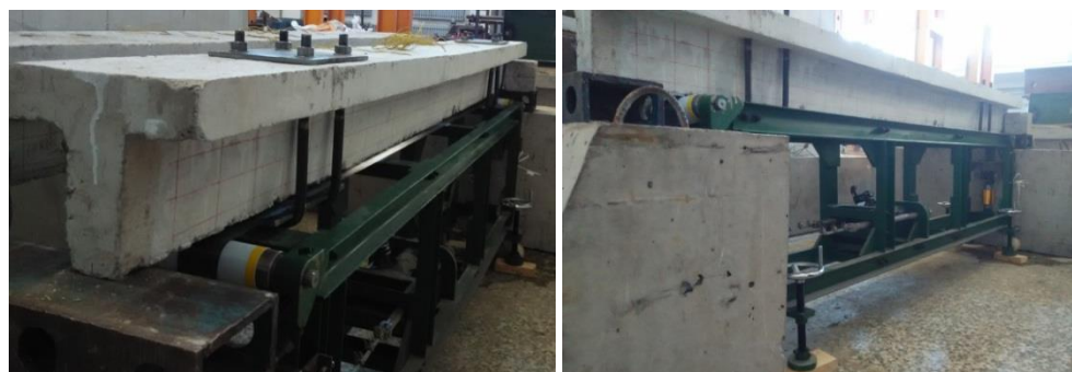
Рис. 3. Процесс комбинированного усиления бетонных тавровых балок
