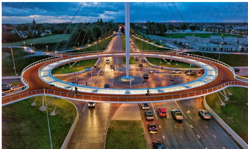
Рис. 5. Вантовый кольцевой велосипедный мост в Голландии ( http://alkatrion.com/?p=38752 )
