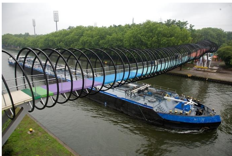
Рис. 8. Мост Slinky Springs в Германии ( http://www.liveinternet.ru/users/2492363/post313559431/ )
