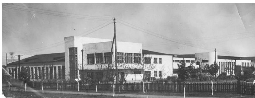
Рис. 7. Ремонтная мастерская. 1930-е гг. (Из фондов Зерноградского историко-краеведческого музея)
