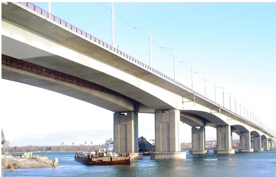
Рис. 1. Общий вид руслового пролетного строения по схеме (84.00 + 2 × 105.00 $ 2 × 105.00 + 84.00) м
