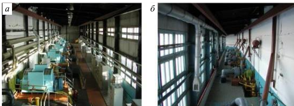
Рис. 1. Машинный (а) и насосный (б) залы газокompрессорной станции
