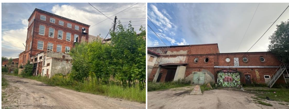
Рис. 4. Юрьевецкая льнопрядильная фабрика. Современное состояние здания, август 2025 г. Фото автора Fig. 4. Yuryevets Flax Spinning factory, 2025
