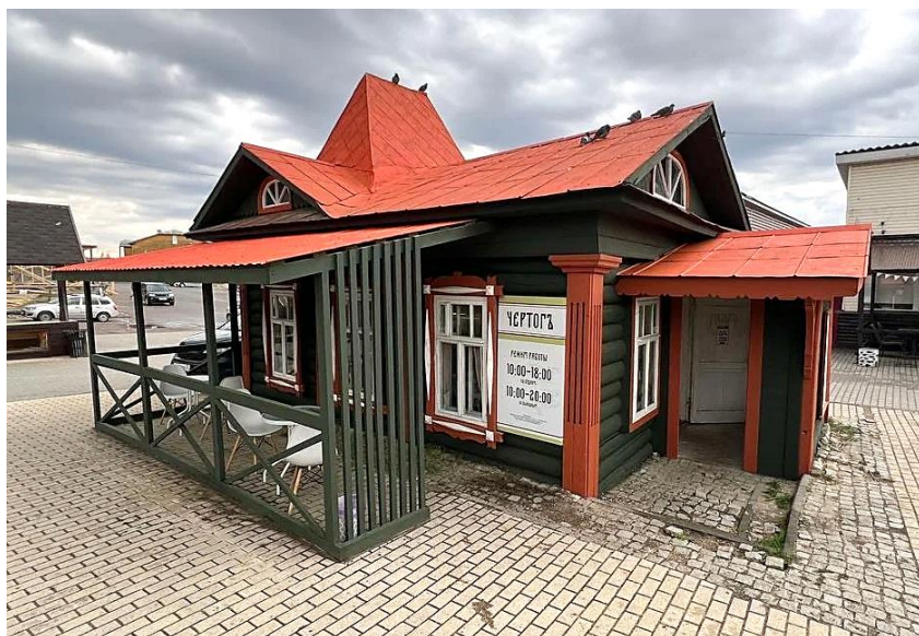
Рис. 22. Торговый павильон. Восточный вид. Архивное фото. 1986 г. [5] (а); торговый павильон. Кофейня «Чертог». Вид юго-западный. Современное фото. Апрель 2025 г. (б)
