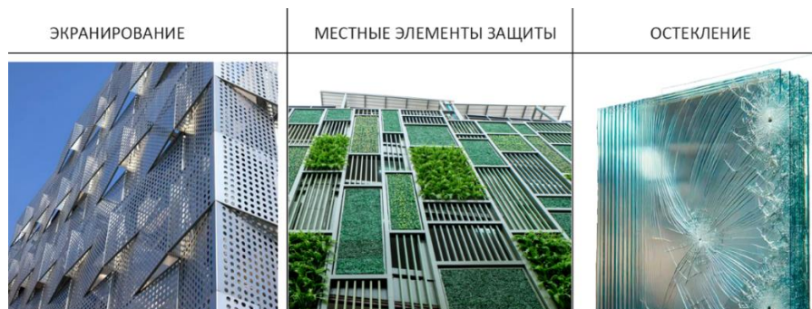
Рис. 4. Фасадные приемы, используемые для защиты жилых зданий от угроз, связанных с атакой БПЛА 3
