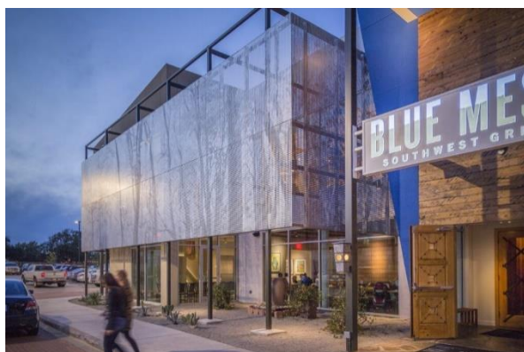
Рис. 2. Фасад из перфорированных металлических панелей ImageWall с узорами от Zahner Labs Fig. 2. Facade from Zahner Labs made of perforated metal ImageWall panels with patterns
