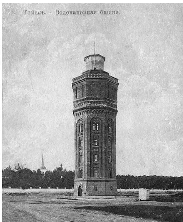
Рис. 2. Водонапорная башня в г. Томске
