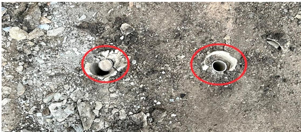
Рис. 12. Подтверждение отсутствия раствора в инъекторе Fig. 12. Confirmation of the solution absence in the injector
