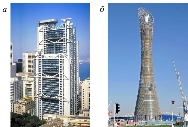
Рис. 3. Ствольные конструктивные системы: a – здание банка HSBC, Китай 4 ; б – Aspire Tower, Катар 5 Fig. 3. Barrel structural systems: a – the HSBC Bank, China; b – Aspire Tower, Qatar
