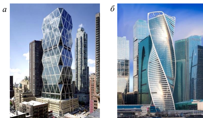
Рис. 1. Каркасные конструктивные системы: a – Hears Tower, США 1 ; б – Башня Эволюция, Россия 2 Fig. 1. Frame structural systems: a – Hears Tower, USA [8]; b – Evolution Tower, Russia
