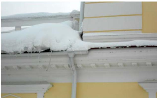
Рис. 10. Дом-музей П.И. Чайковского в г. Воткинске, памятник архитектуры федерального значения. Современные системы водоотведения, установленные в ходе ремонтных работ. Фото Ю.А. Стояк, январь 2015 г.
