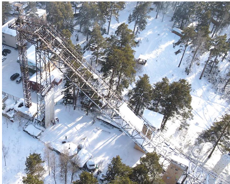
Рис. 1. Общий вид трамплина и лифтовой шахты Fig. 1. General view of the ski-jump and lift shaft
