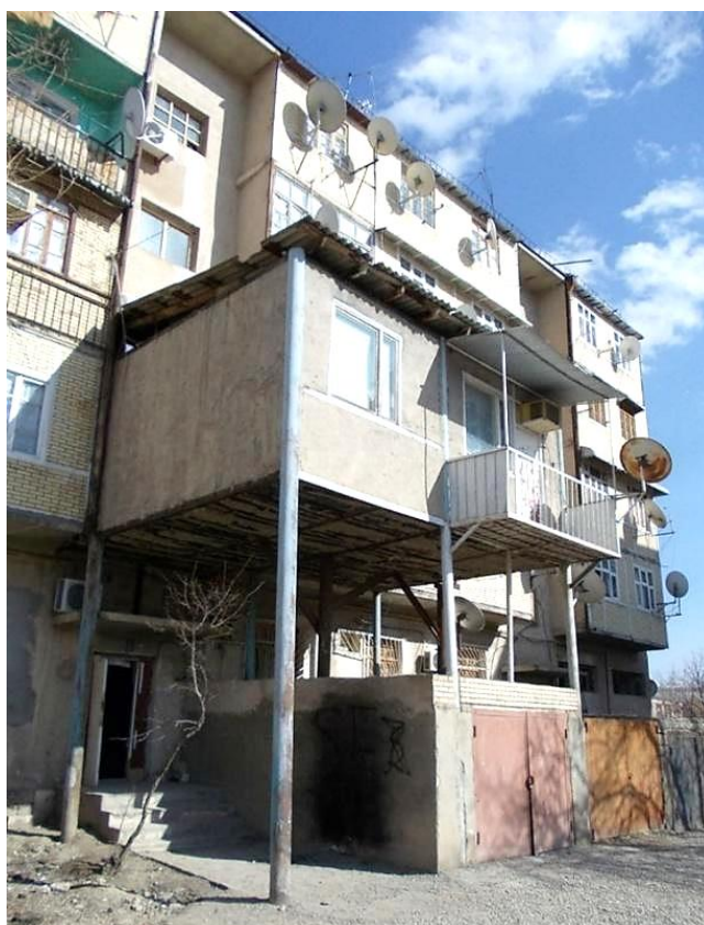
Рис. 4. Вынос балконов и пристройка гаражей 4 Fig. 4. Removal of balconies and garage annexes
