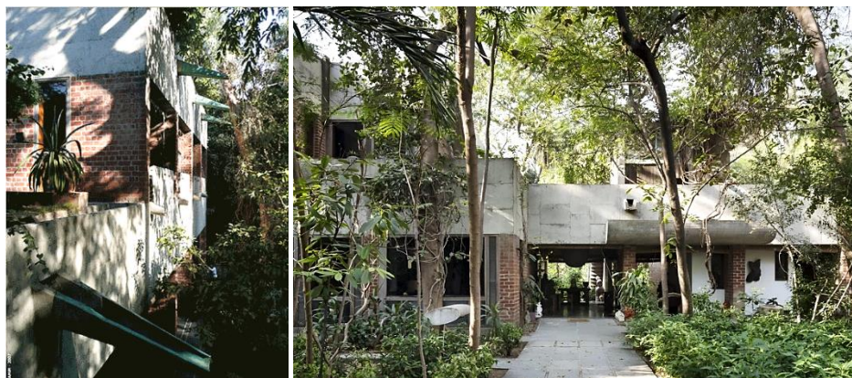
Рис. 15. Вилла Сарабхай. Сочетание кирпичной кладки и бетона на фасадах здания 20 Fig. 15. A combination of brickwork and concrete on facades of the Villa Sarabhai
